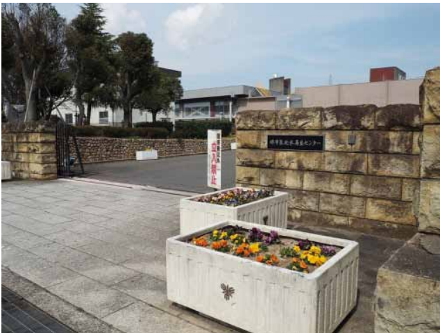
堺市泉北水再生センター
