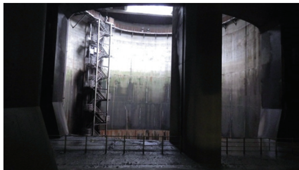
直径 30m もある立坑
