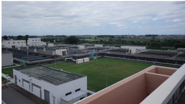
管理本館屋上からの浄水場全景
