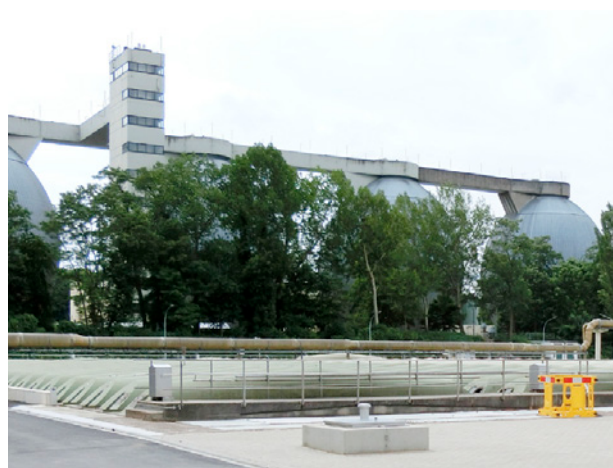
下水汚泥消化タンク
