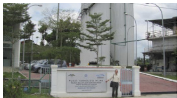
写真4 パームオイル排水処理プラント
