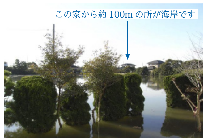
我家の被災状況－床下浸水(塩水)
