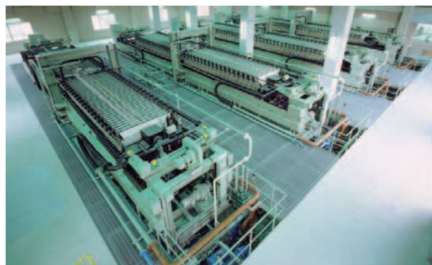
図4 浄水場での無薬注加圧圧搾脱水機の設置例
