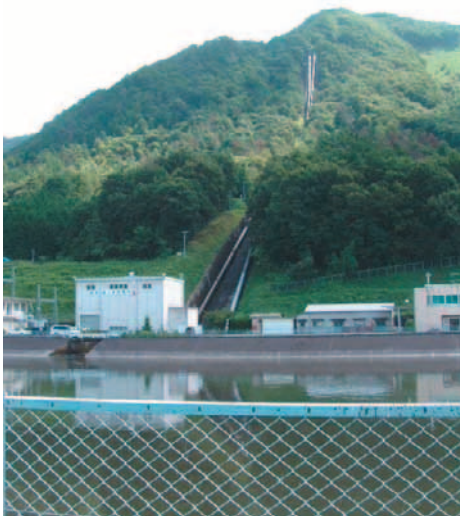
柚木発電所 調整池から発電所を臨む
