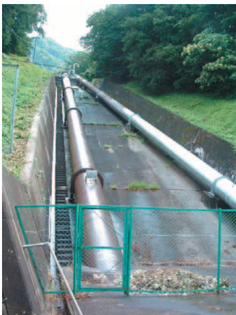
柚木発電所 水路
