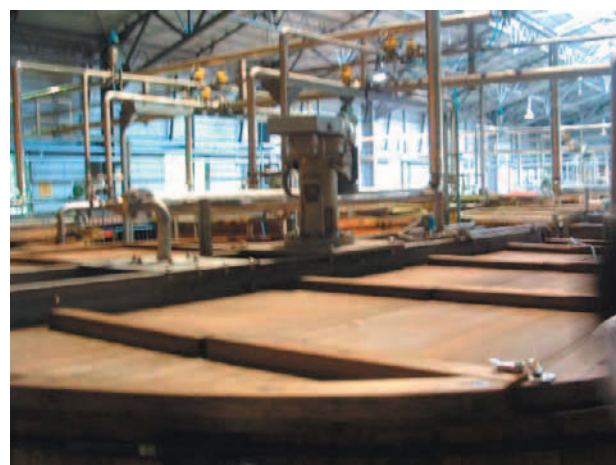
サントリー白州蒸溜所 発酵槽
