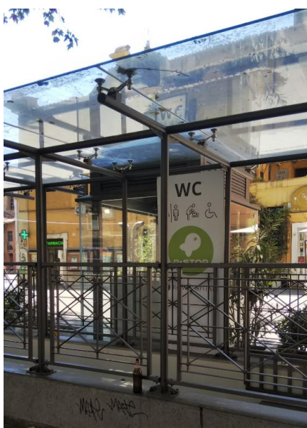
地下公衆トイレ
